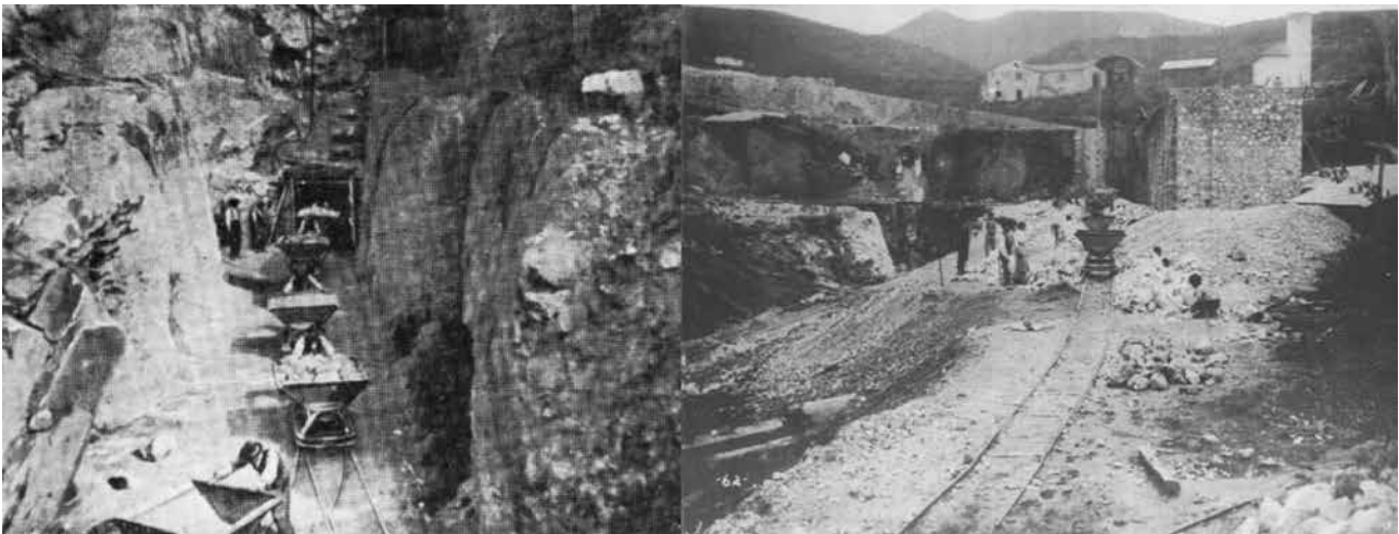
Figura 14: operai addetti alla movimentazione dei carrelli in uscita dalla galleria della miniera del Masaccio (a sinistra) e partenza dei carrelli dal silo verso la fornace (a destra) [26].
