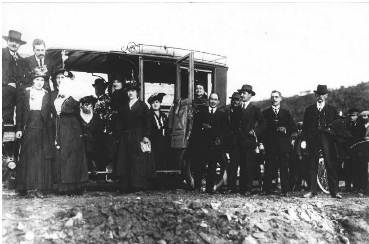
Figura 24: Campolecciano 1916, scene della inaugurazione degli impianti di trattamento minerale.
