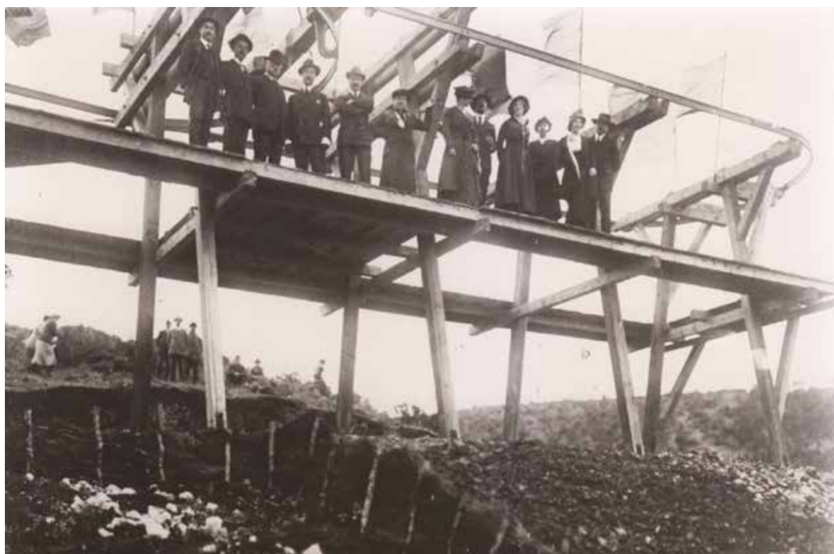
Figura 25: Campolecciano 1916, altre scene della inaugurazione degli impianti di trattamento minerale.
