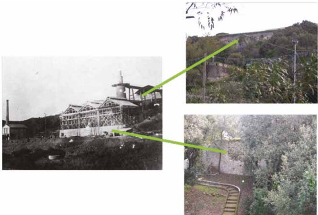
Figura 27: dei fabbricati per la calcinazione del minerale e per la produzione dei mattoni ormai rimane ben poco. Nella foto la freccia in alto mostra i resti del muro che sosteneva il piano di arrivo dei carrelli al forno di calcinazione in corrispondenza della attuale terrazza dell'area ex istituto alberghiero mentre la freccia in basso indica i resti dell'edificio dei magazzini.
