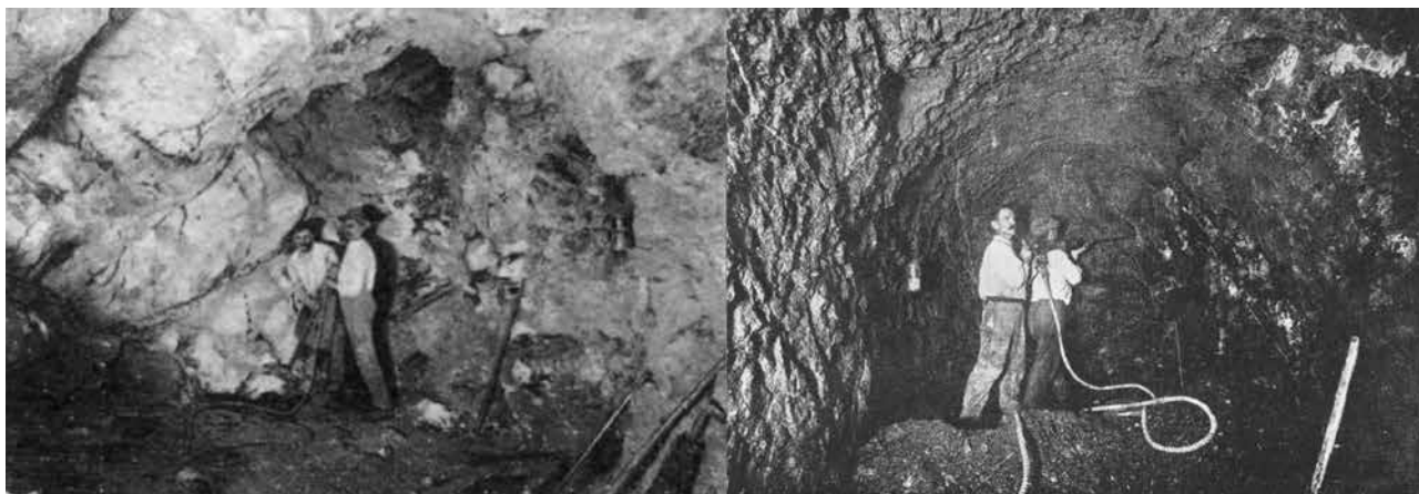
Figura 19: miniera del Masaccio, estrazione in galleria: abbattimento di magnesite in una traversa del primo livello a sinistra e galleria di avanzamento primo livello a destra.
